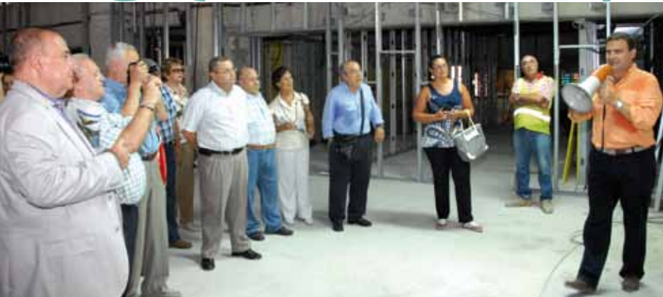
LA AAPET DE ALICANTE VISITA LAS INSTALACIONES DEL TRAM
